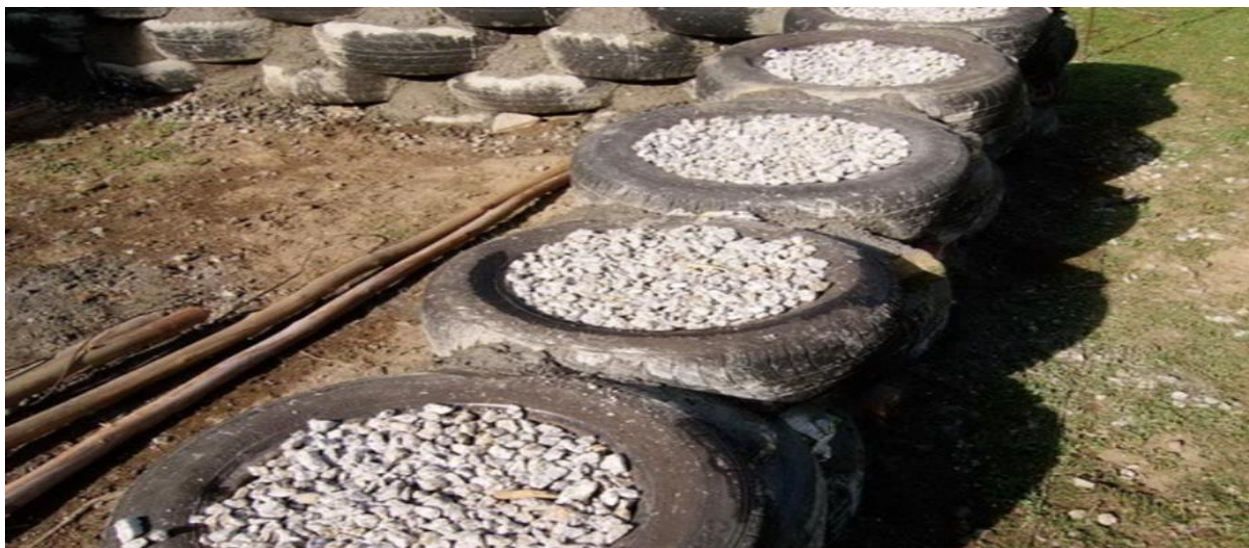
3.10-rasm. Shinalar orasidagi bo‘shliqlarni hamda shinalarning ichki bo‘shliqlarini to‘ldirish.
