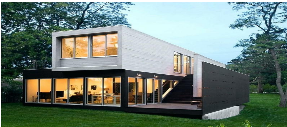
3.6-rasm. Yuk konteyneridan tiklangan ikki qavatli uy.
